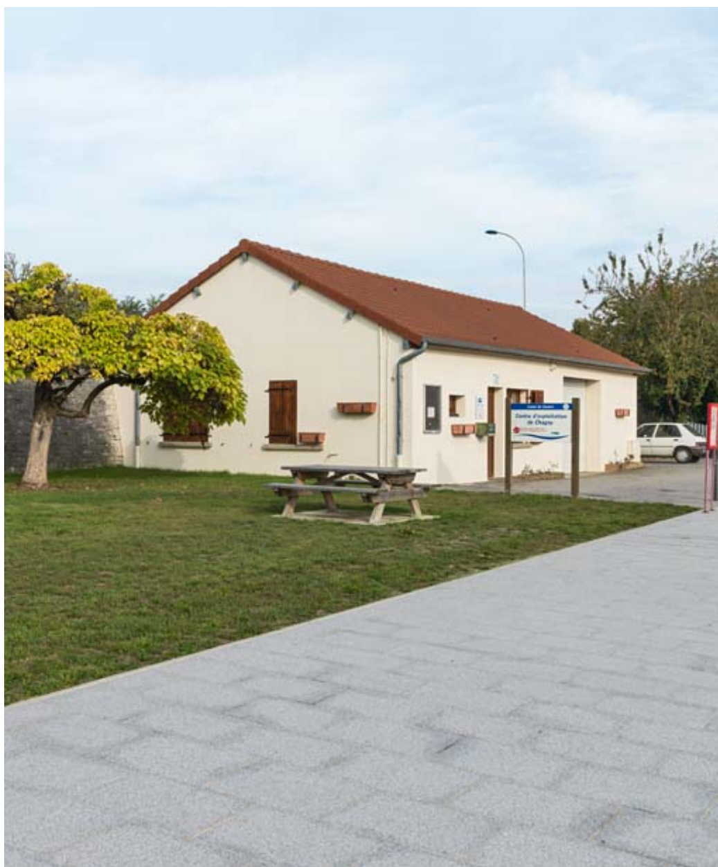
Vue d'ensemble de la maison de garde.
