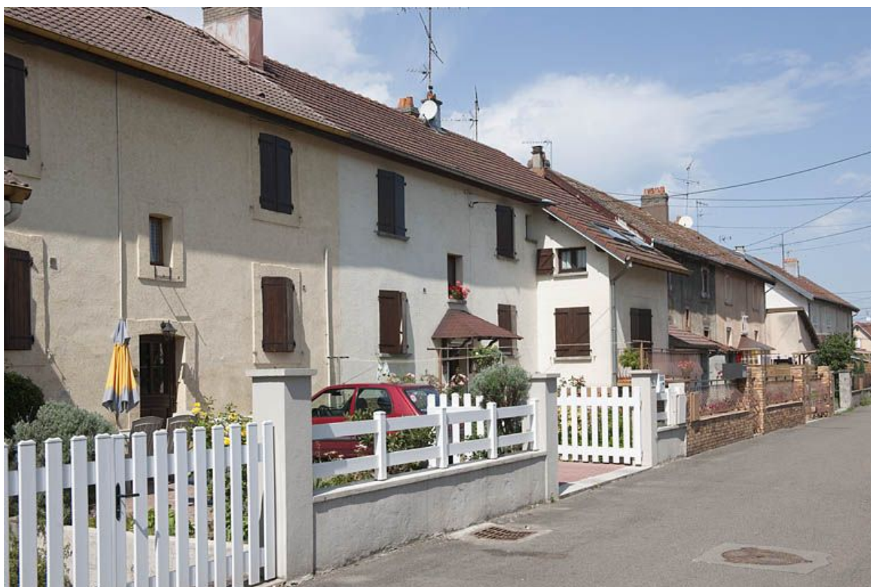
Alignements de maisons sur la rue.
