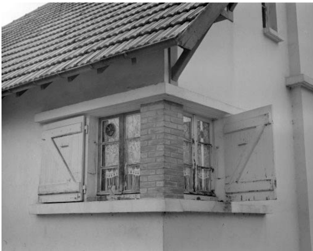
Maison (B) : fenêtres d'angle.
