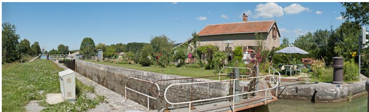
Vue d'ensemble du site d'écluse.
