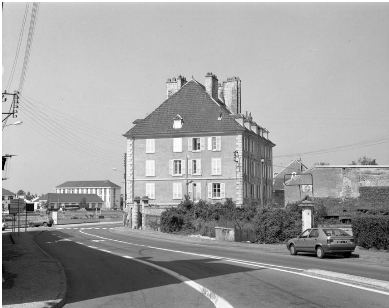
Vue de la façade latérale droite.
