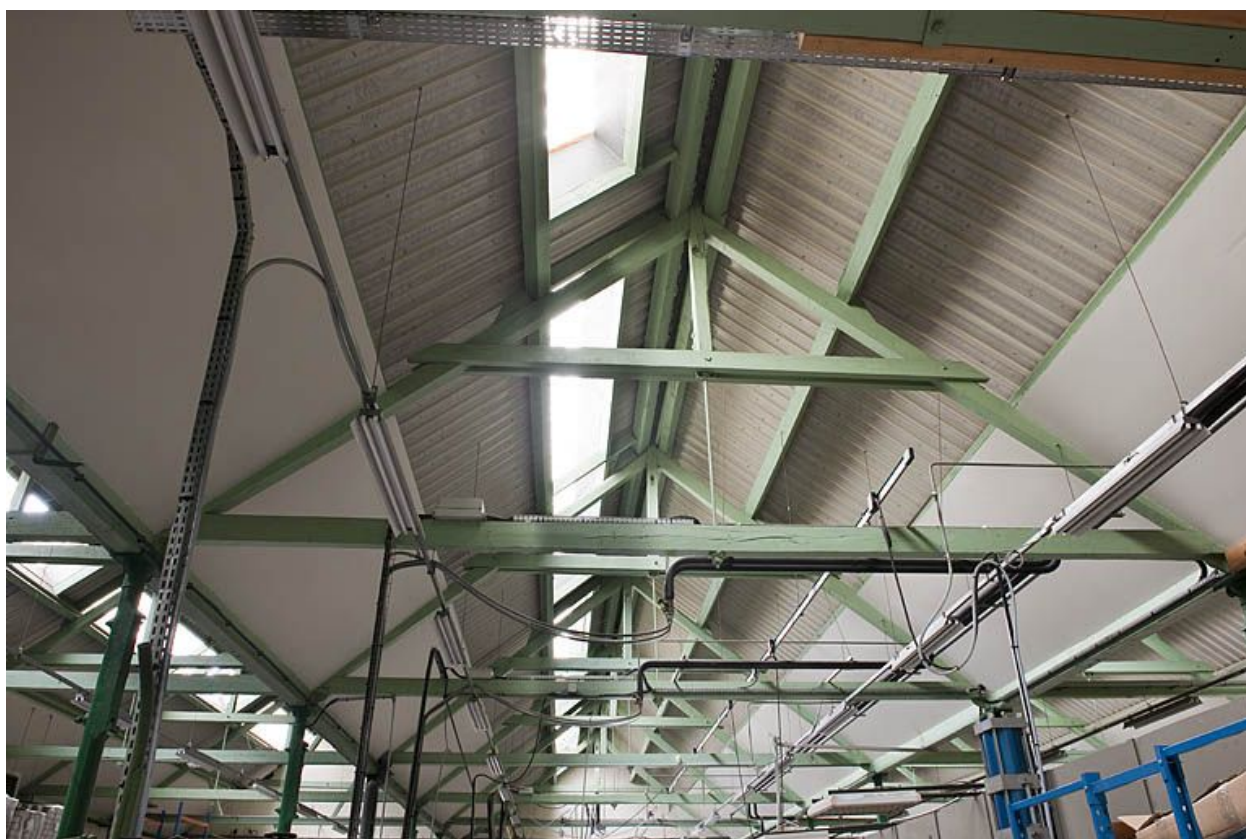
Charpente de l'atelier de finition.
