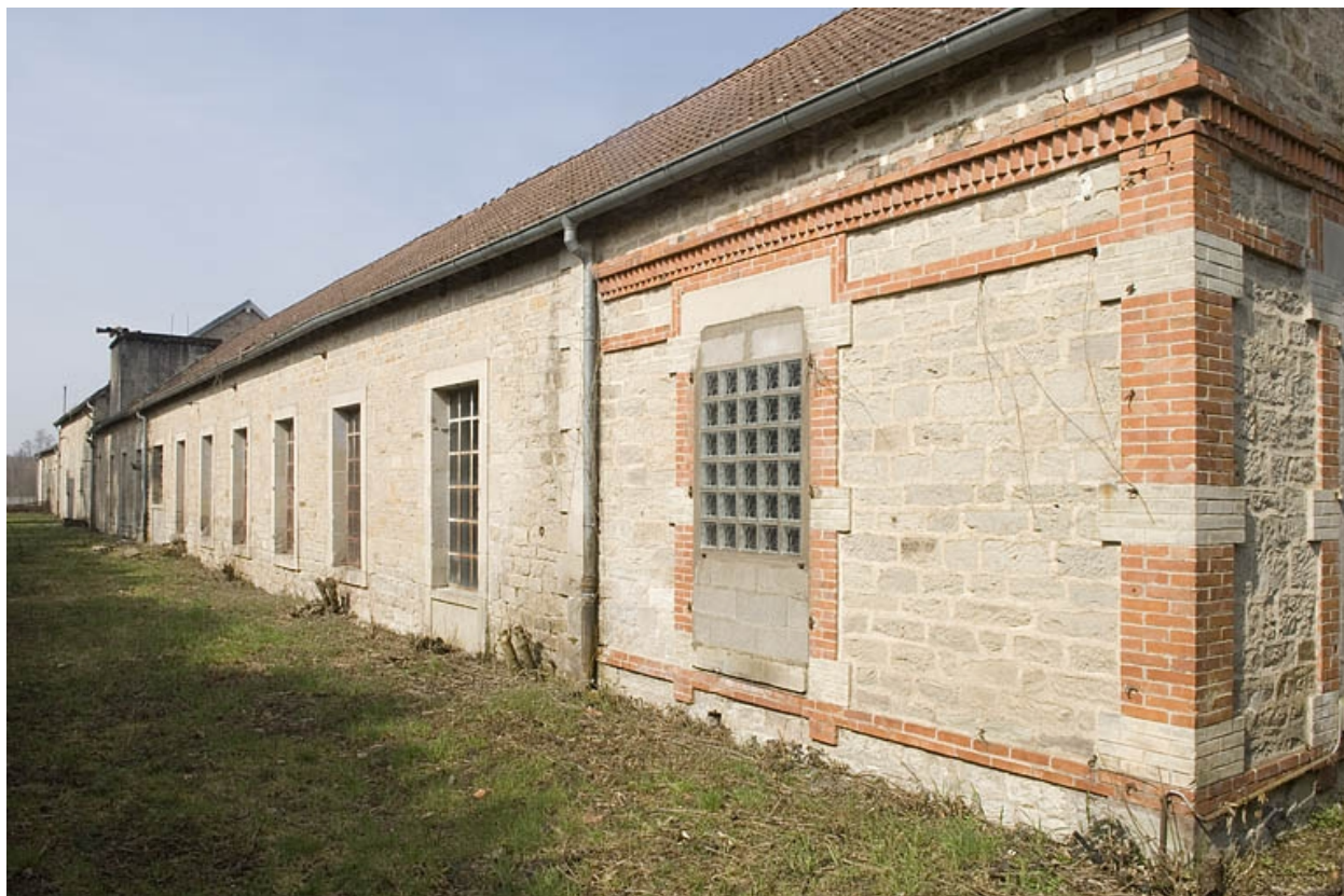
Façade sud vue de trois quarts droite.
