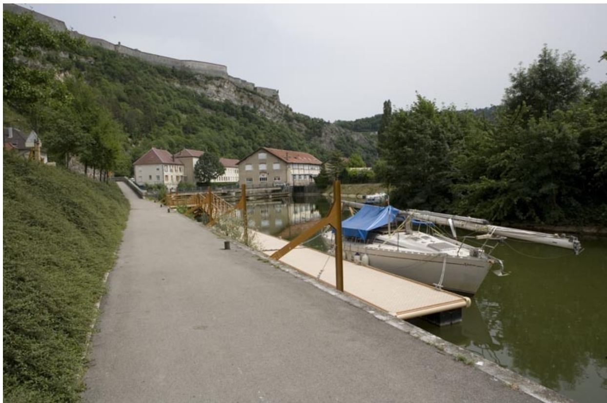
Vue d'ensemble rapprochée depuis l'amont.
