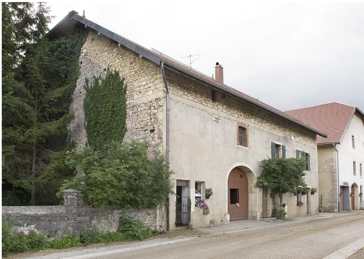
Ferme au 4 rue du Faubourg (2008 AB 47).
