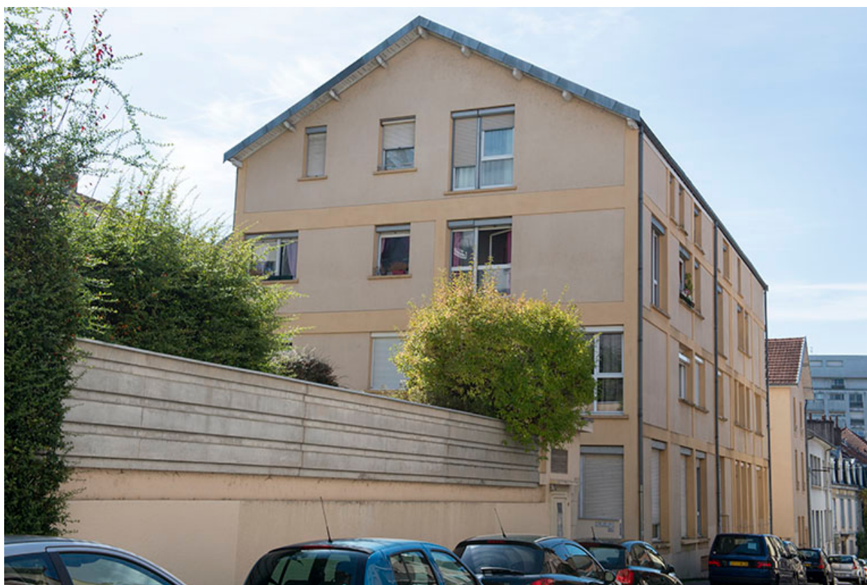
Vue depuis le nord.
