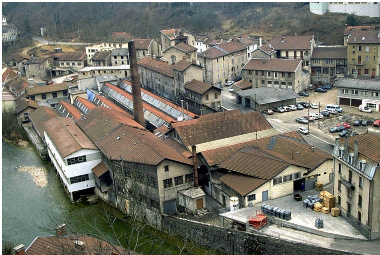
Vue d'ensemble plongeante sur l'usine, depuis l'ouest.
