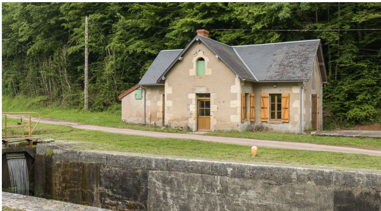
La maison éclusière de 3/4.
