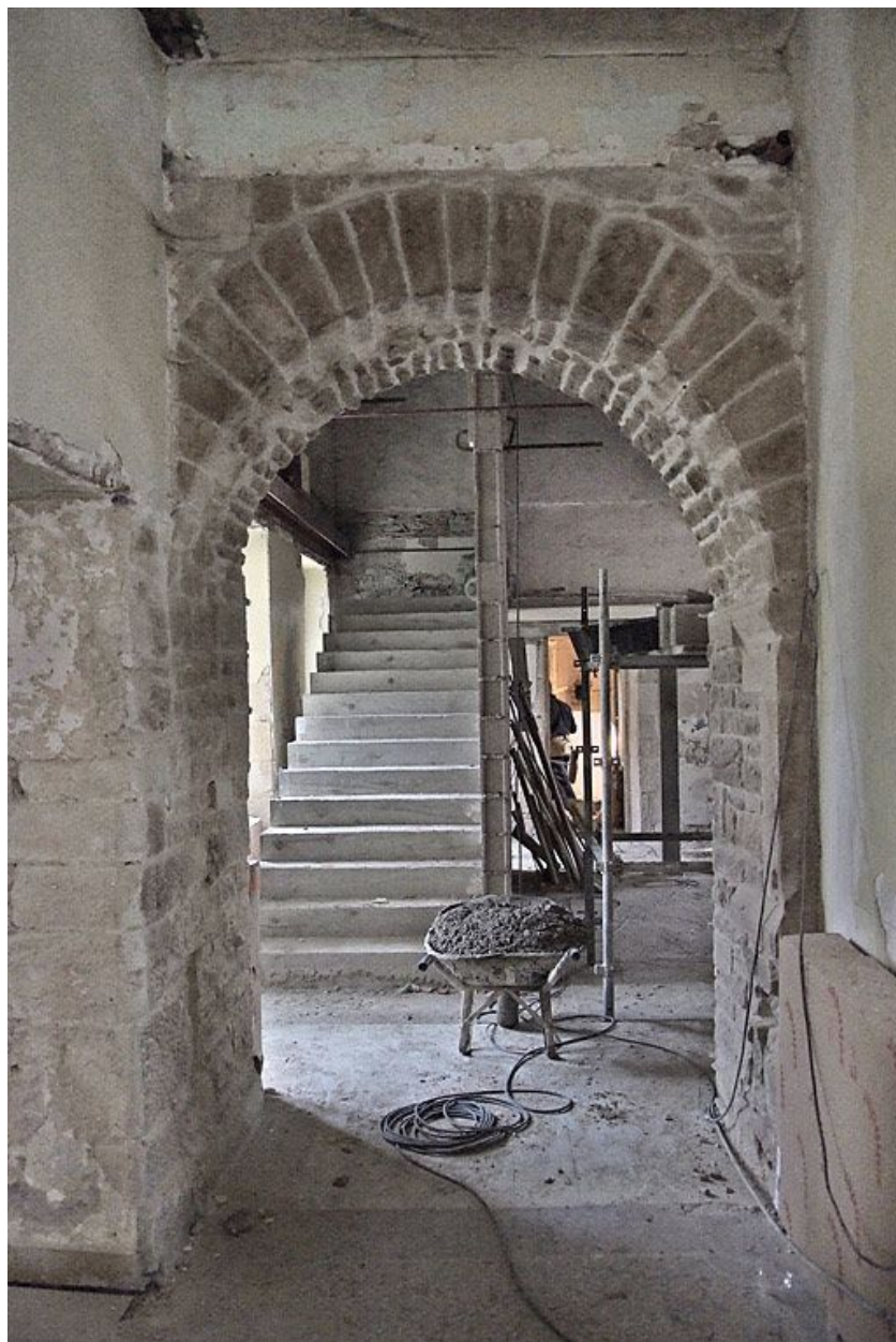
Couloir et escalier pendant les travaux.
