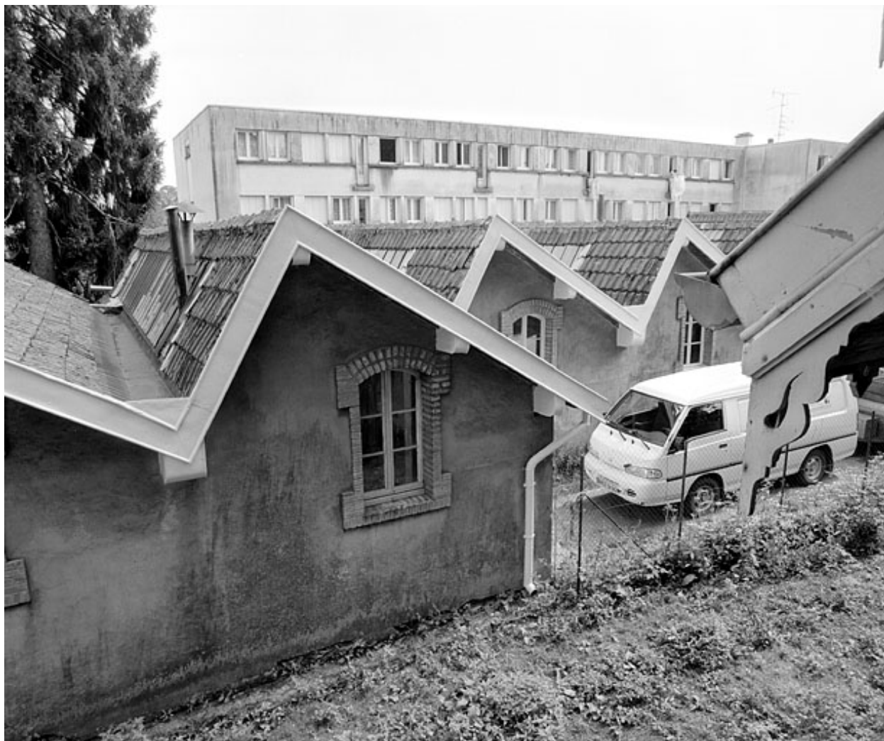
Sheds de l'atelier de fabrication.
