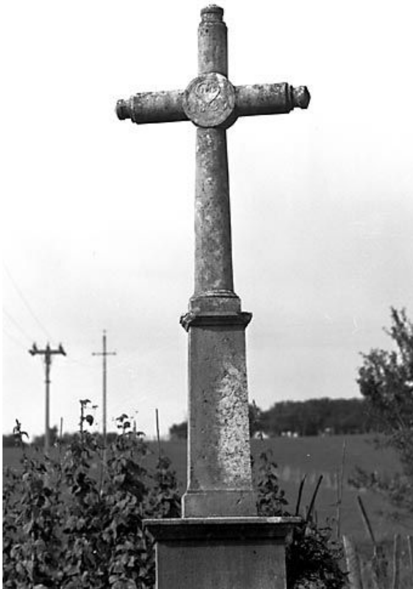
Croix de chemin située Grande Rue.
