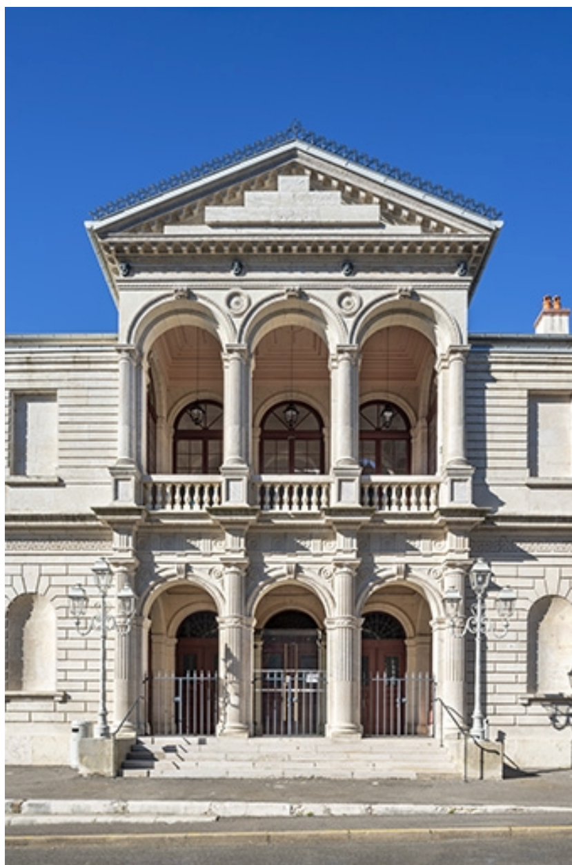
Façade antérieure : travées centrales.
