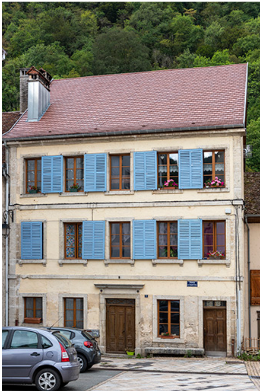
Immeuble 3 place du Chapitre : façade antérieure.
