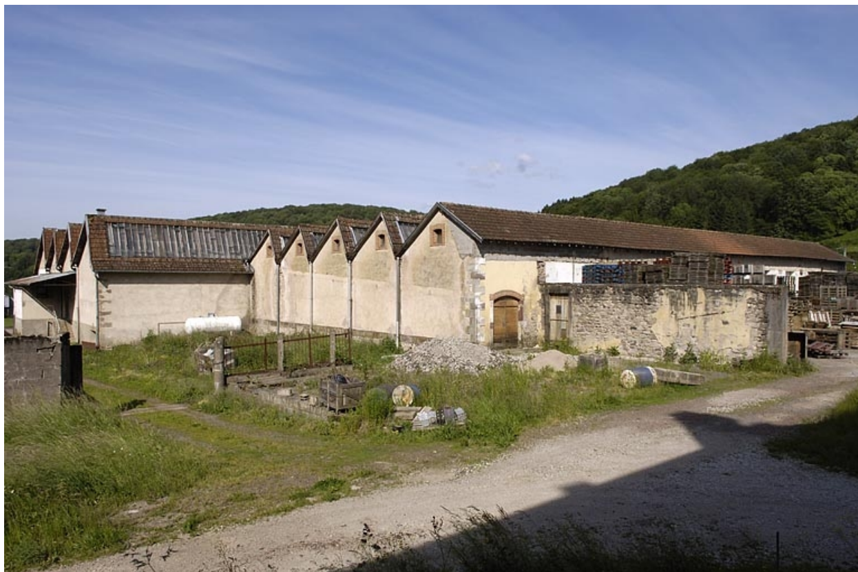
Les ateliers de filature vus depuis l'est.
