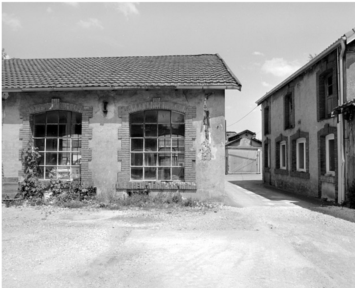
Magasins généraux : atelier.
