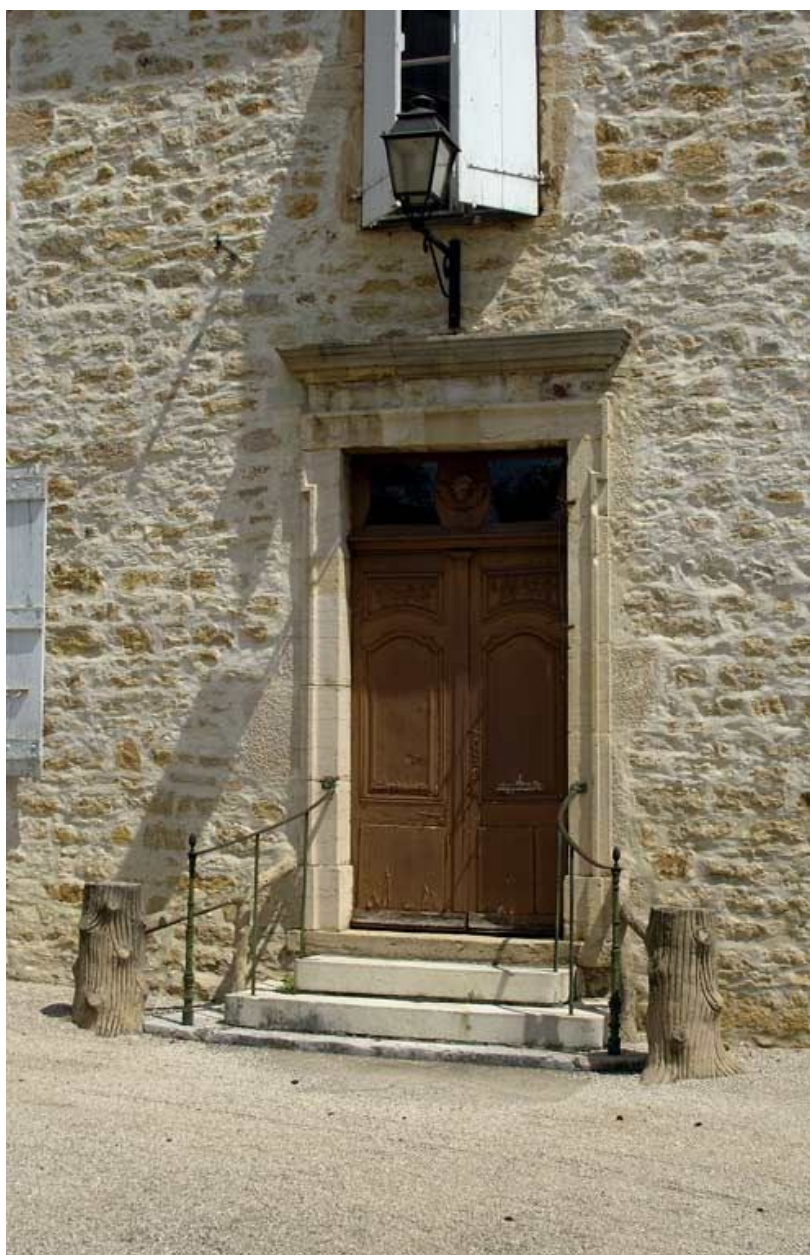
Façade antérieure, détail de l'ancienne porte d'entrée.
