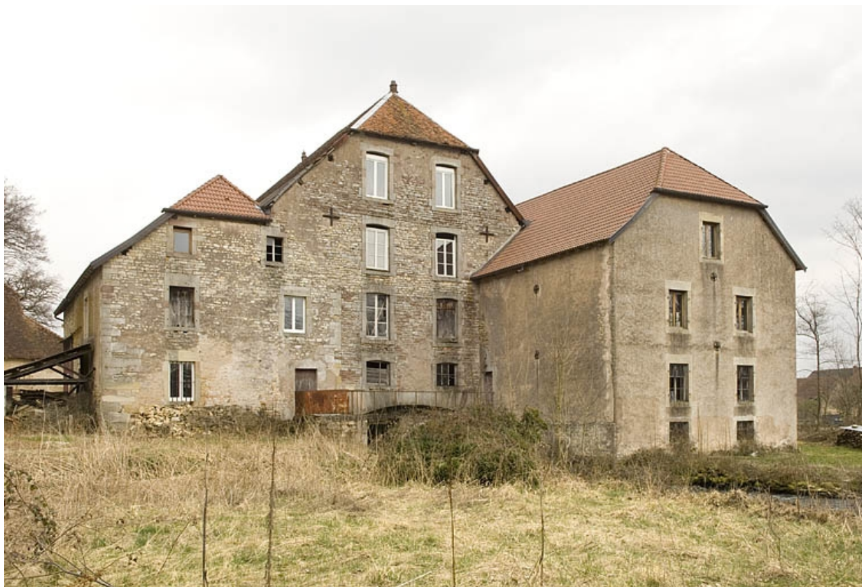
Vue de trois quarts, depuis l'ouest.
