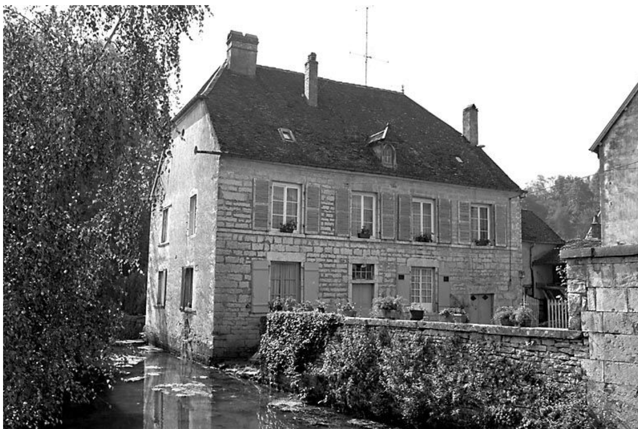
Façade antérieure de l'habitation.
