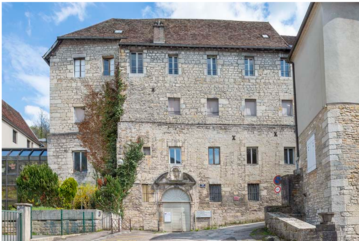
Extrémité nord du bâtiment, depuis l'ouest.
