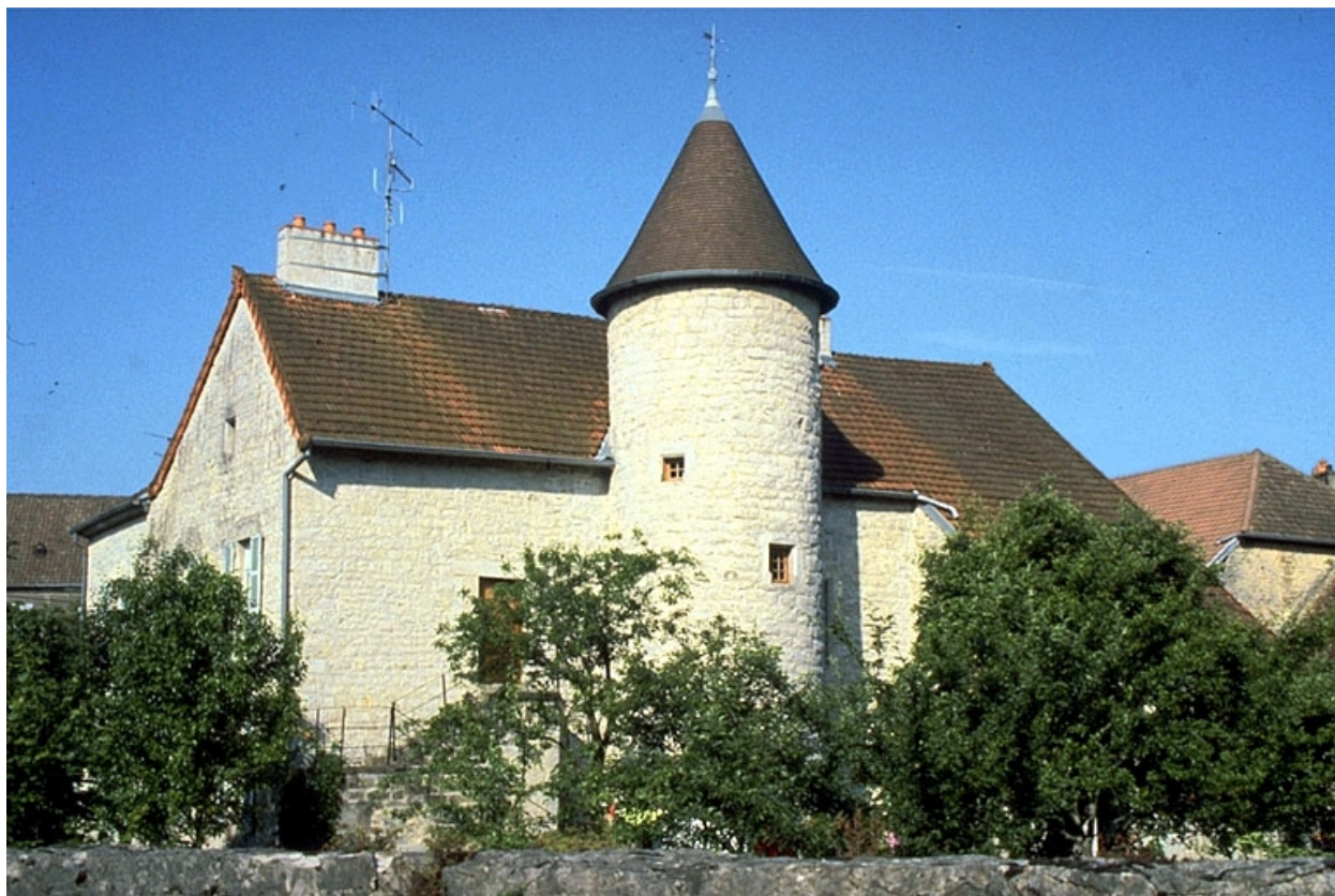
Façade postérieure vue de trois quarts gauche.
