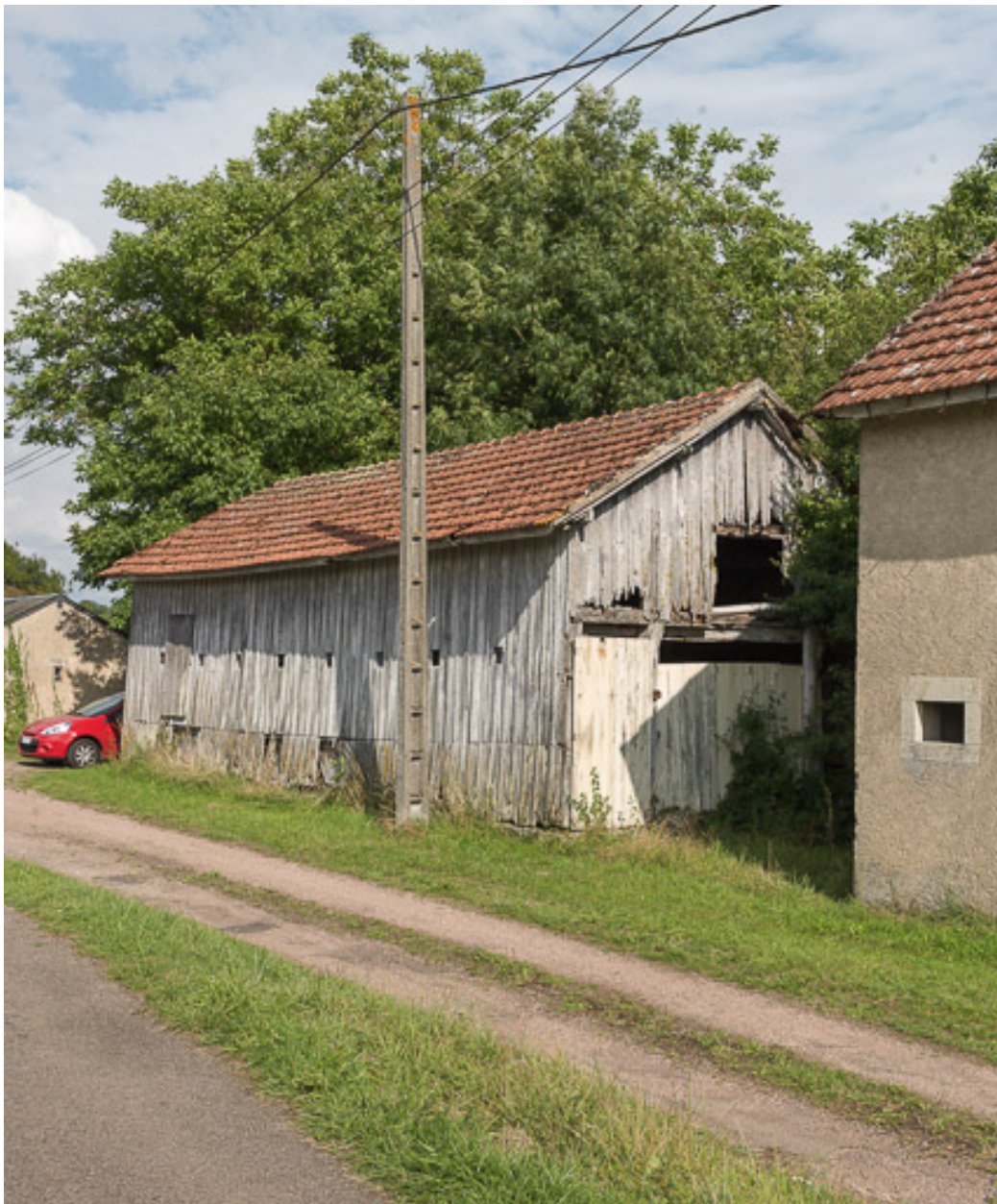
Vue de l'extension de la maison éclusière.
