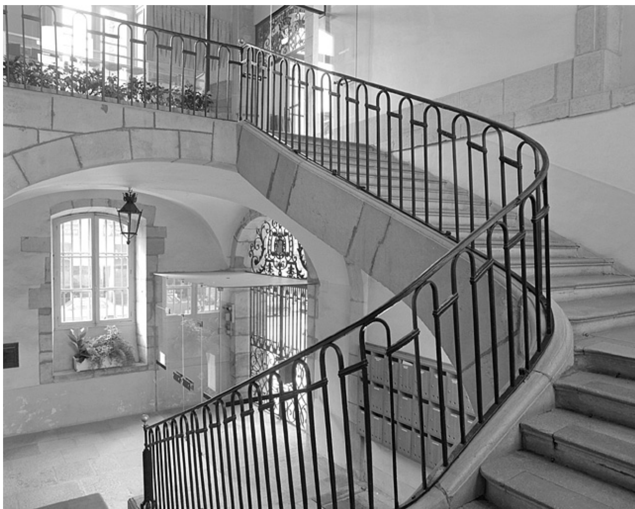
Grand escalier : dernière volée et palier.
