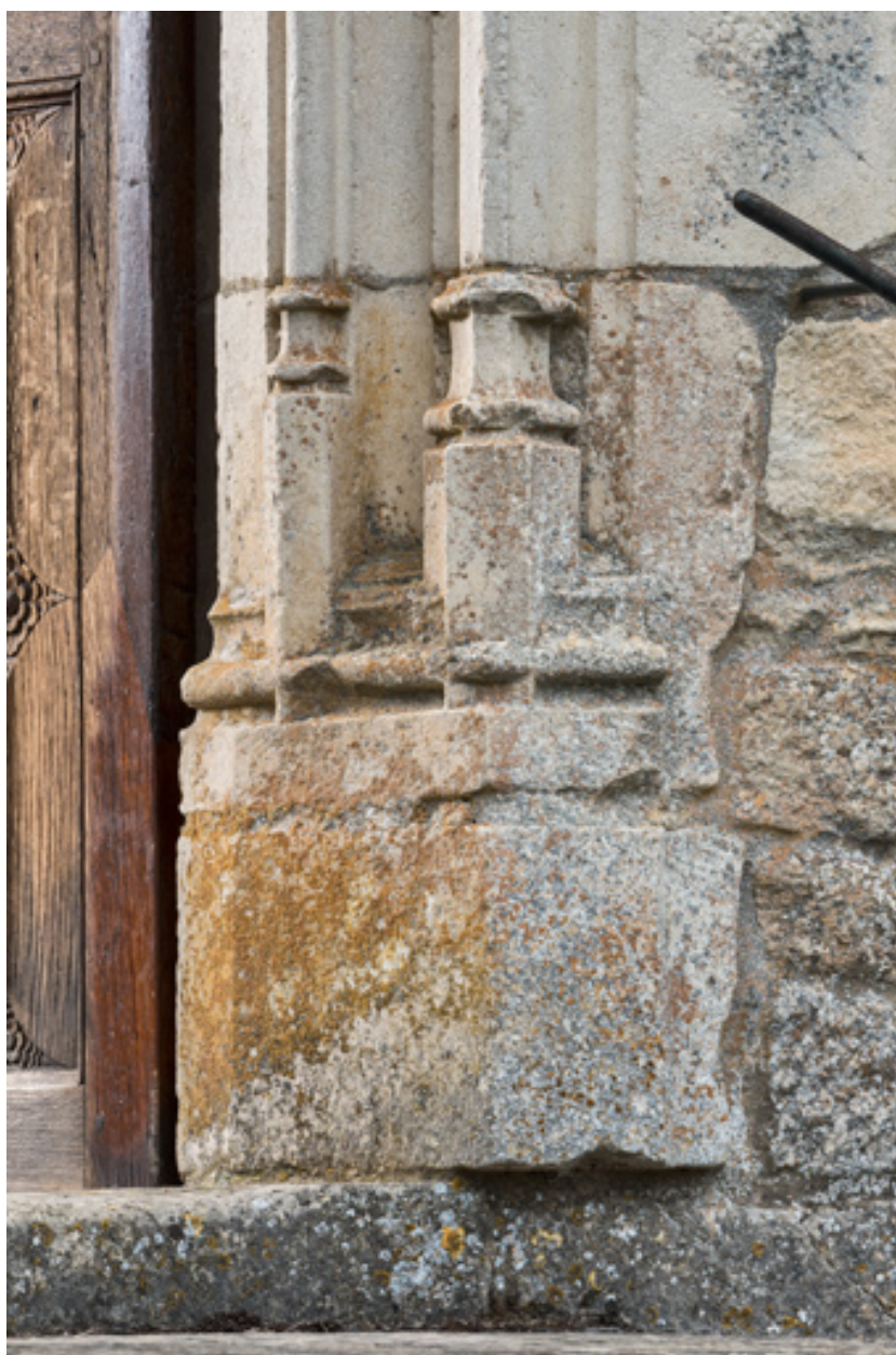
Piédroit, détail de la partie inférieure, droite.
