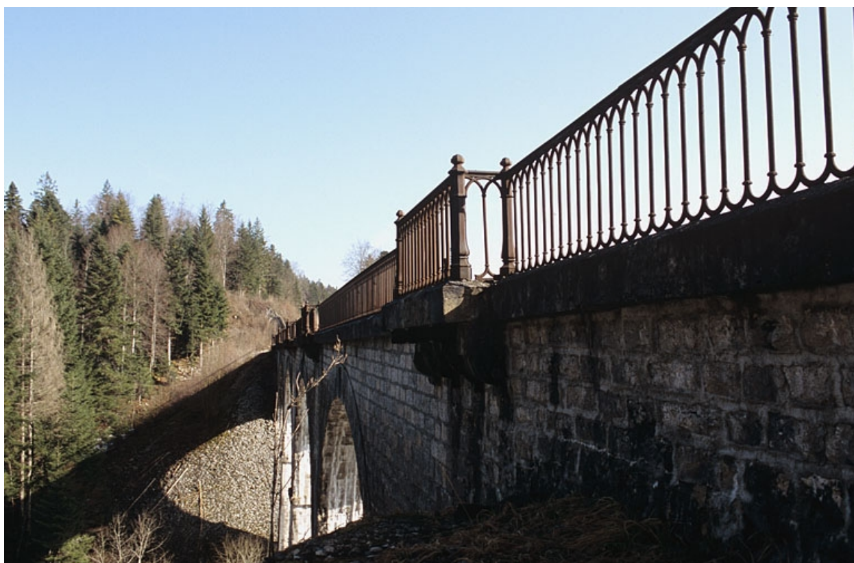
Garde-corps de l'élévation occidentale.
