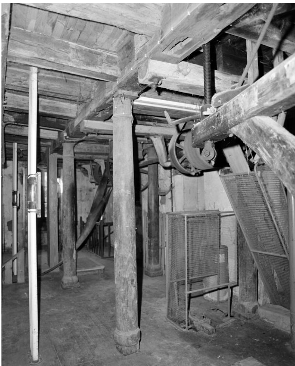
Rez-de-chaussée. Arbre de transmission et poulies.
