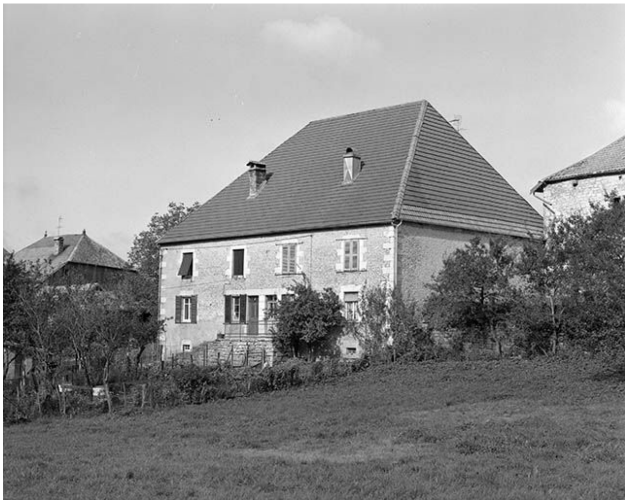
Façade postérieure et face latérale gauche.
