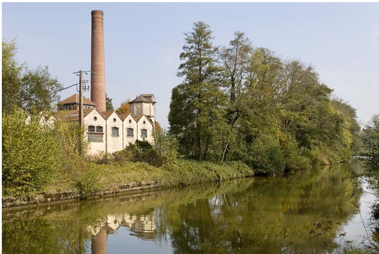
Vue d'ensemble depuis le sud du canal.
