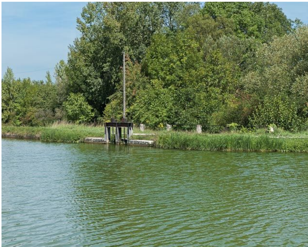
Vue du déversoir sur la rive droite
