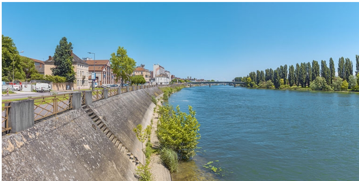
Le quai vu d'aval.
