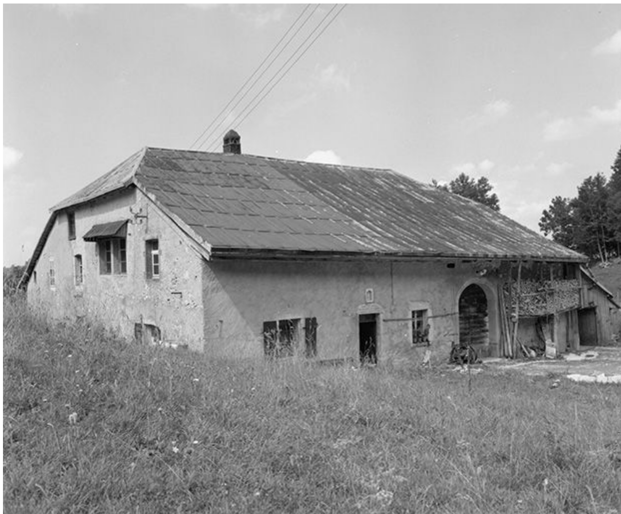
Façades antérieure et latérale gauche.
