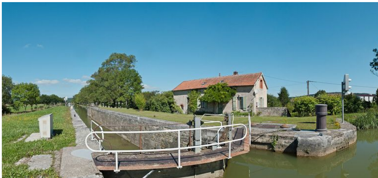
Vue d'ensemble du site d'écluse.
