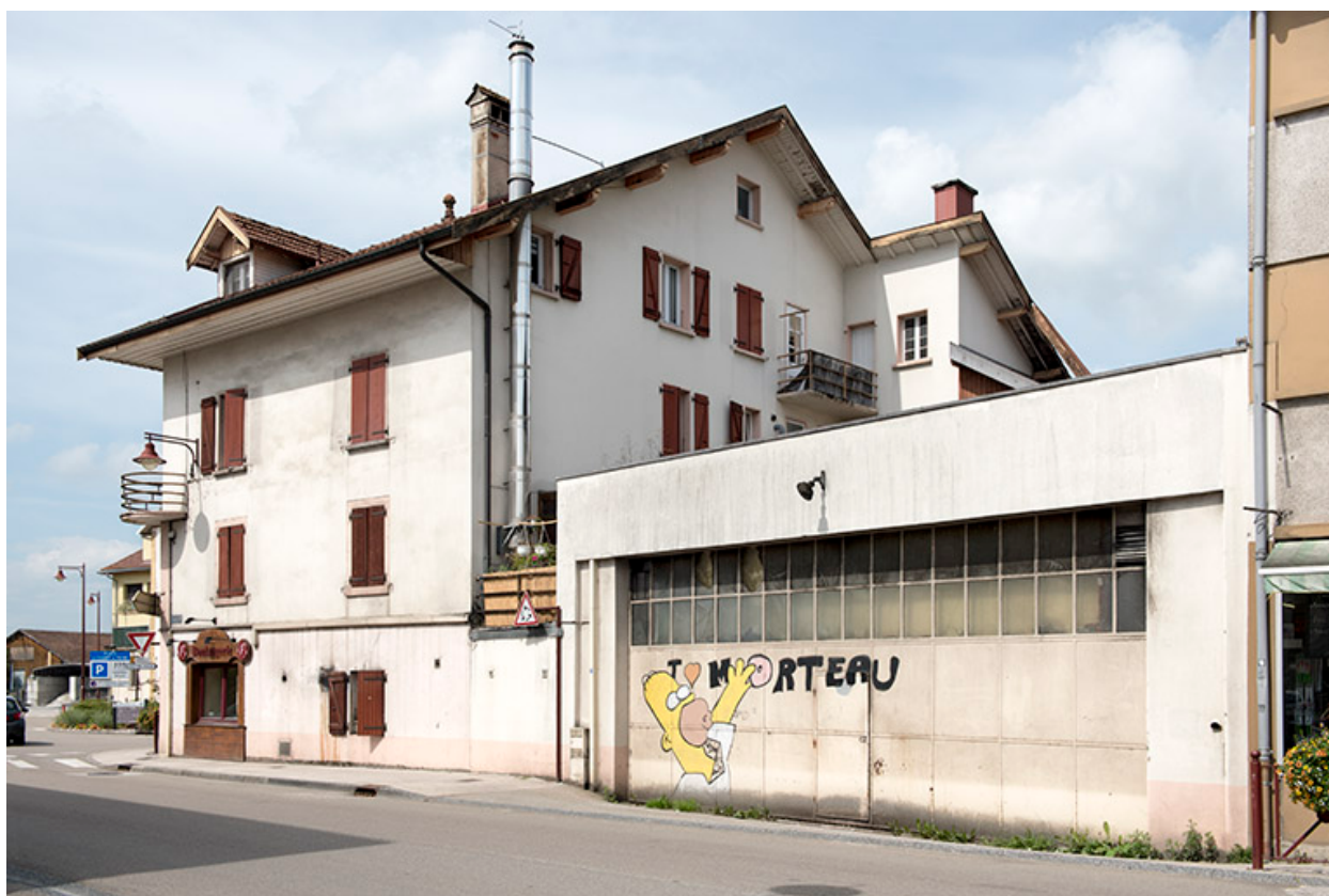
Façade latérale droite.
