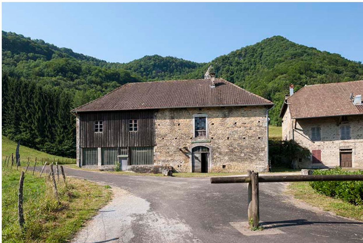
Façade antérieure de l'atelier de fabrication.
