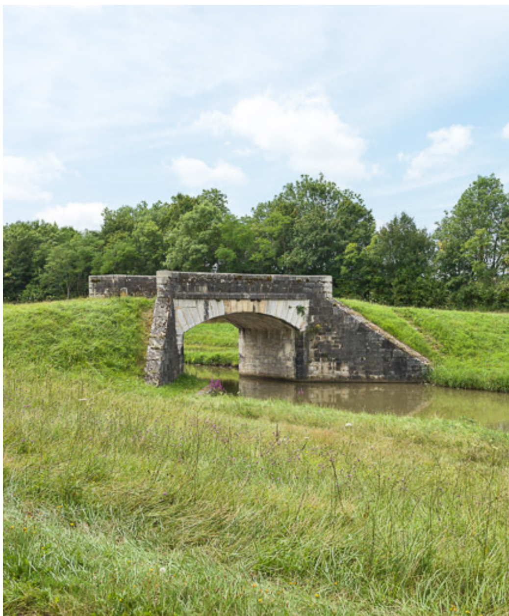
Vue du pont.
