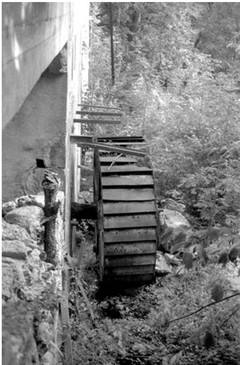
Roue hydraulique verticale amont.
