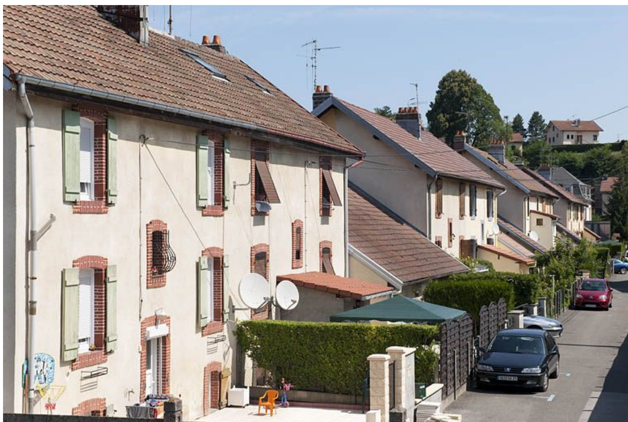
Vue d'ensemble des maisons rue de Reims.
