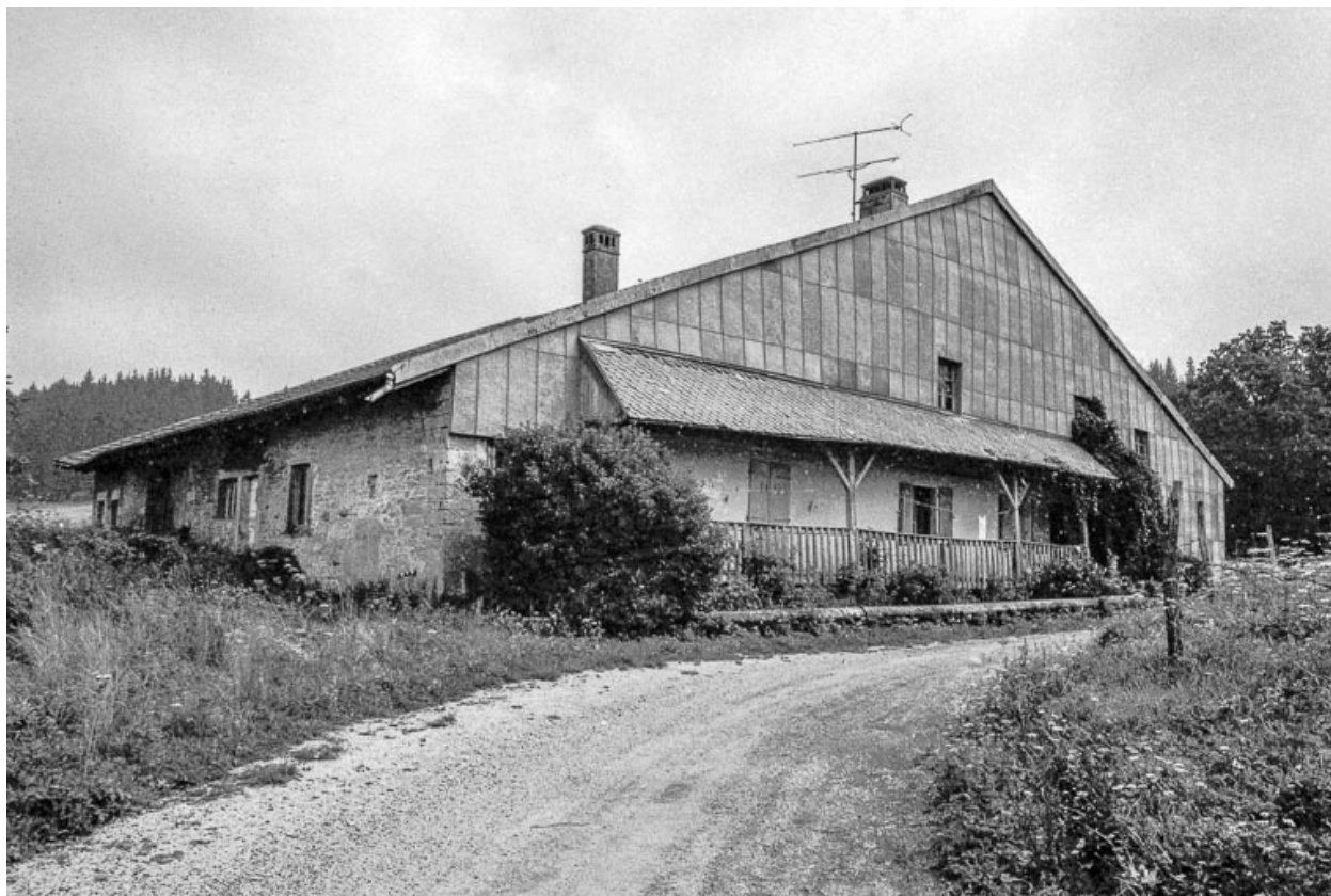
Ferme située au lieudit Montorge.
