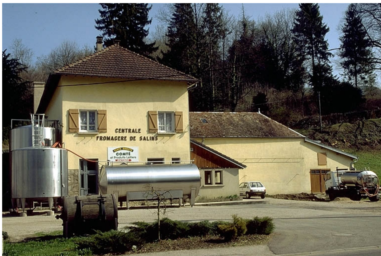
Façade antérieure depuis la route.
