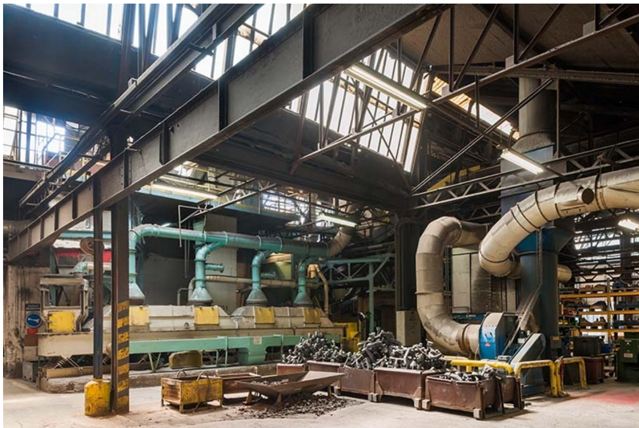
Vue d'ensemble. Ossature métallique.
