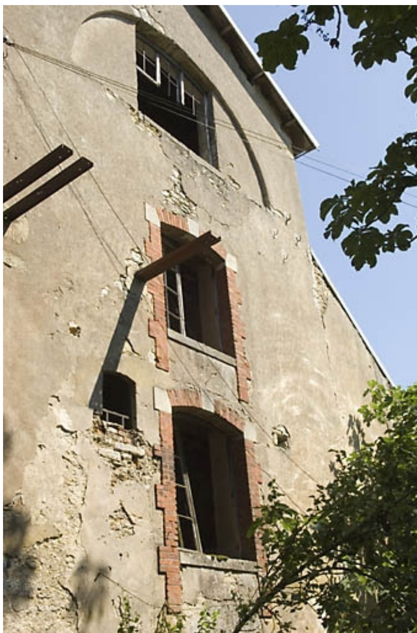
Elévation du pignon sud du haut fourneau.
