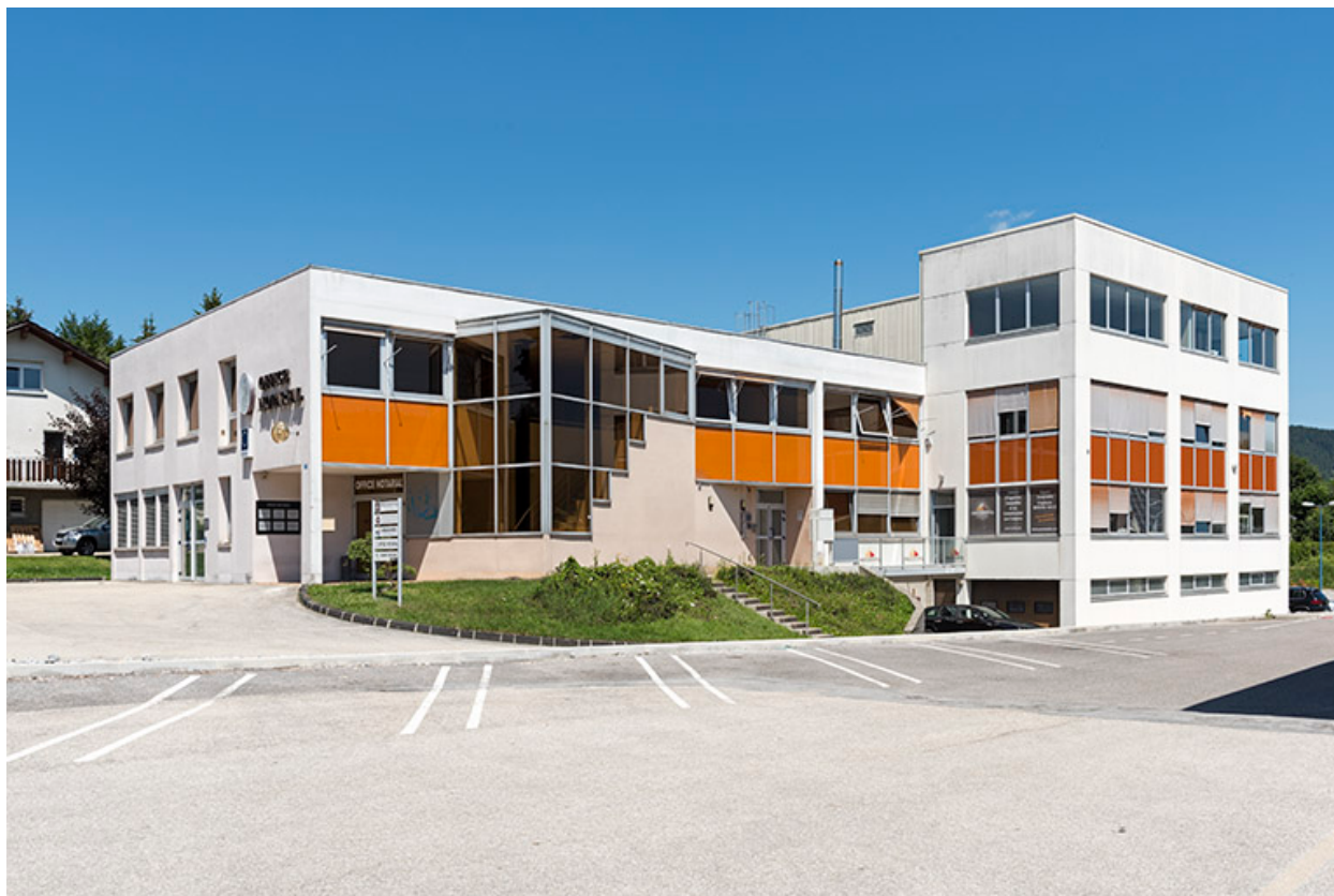
Usine d'horlogerie Charpier-Rième, 3 chemin des Pierres.
