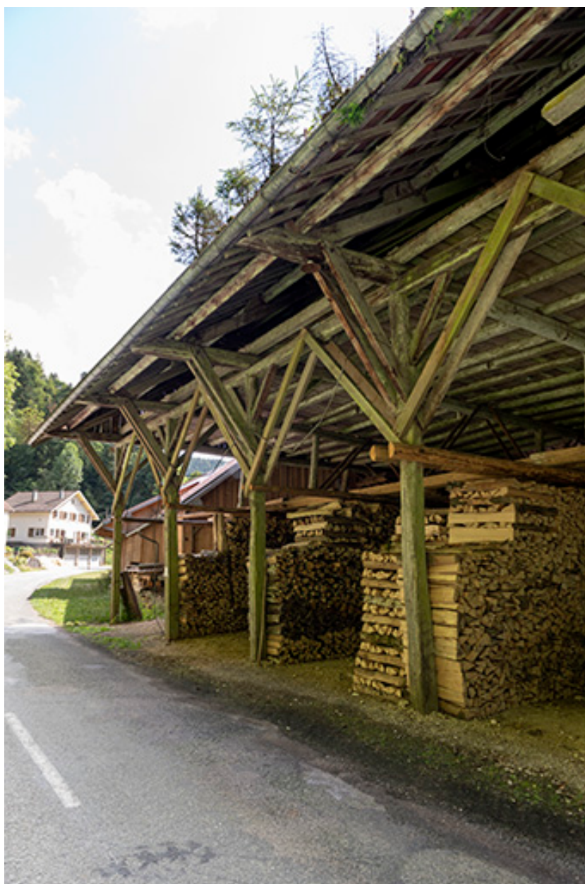
Hangar, depuis le nord.
