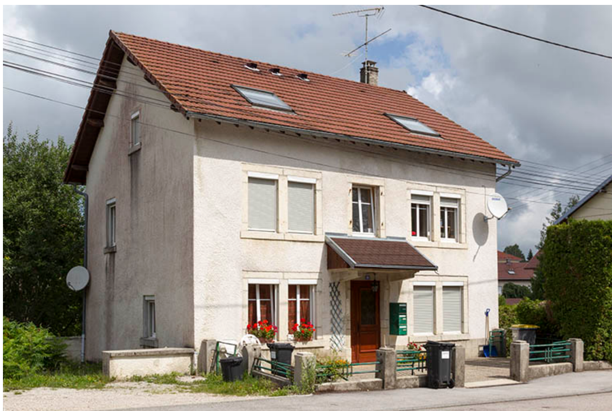
Logement patronal : façades antérieure et latérale gauche.
