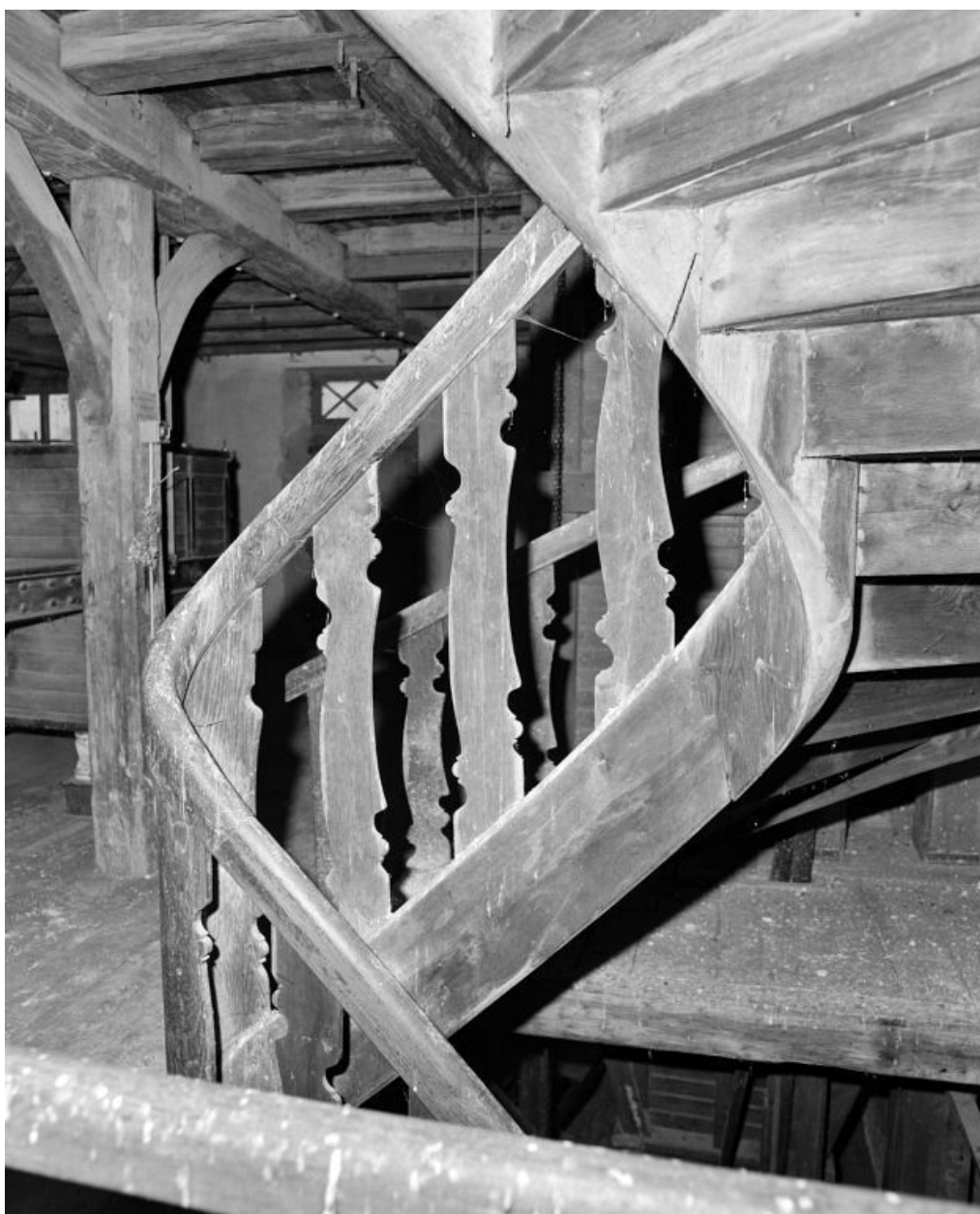
2e étage. Escalier, détail de la volée.
