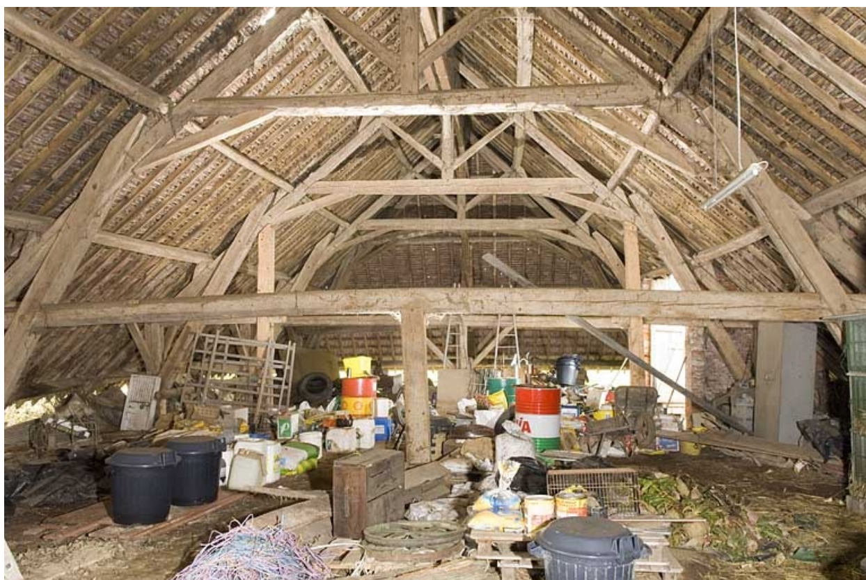
Tuilerie et briqueterie, Champtonnay : charpente du séchoir.
