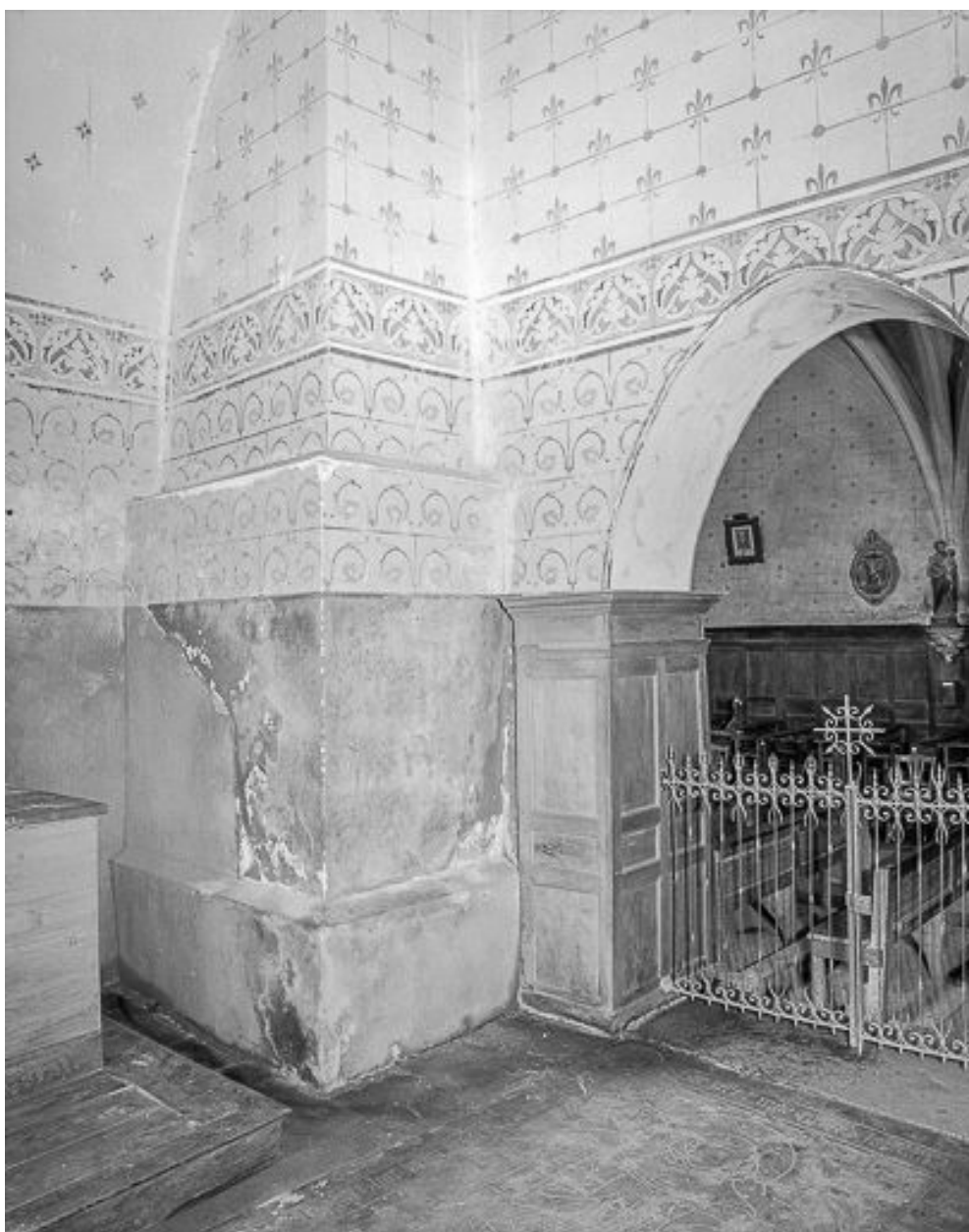
Intérieur : angle antérieur gauche de la nef.
